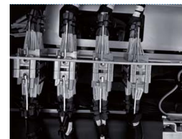
Пример, реализованный в кабине машиниста на 4 линии метрополитена в Хэфэй
