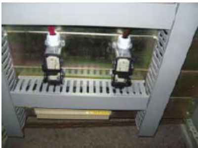
■ Комплектная трансформаторная подстанция (КТП)
