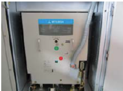
■ Вакуумный выключатель
